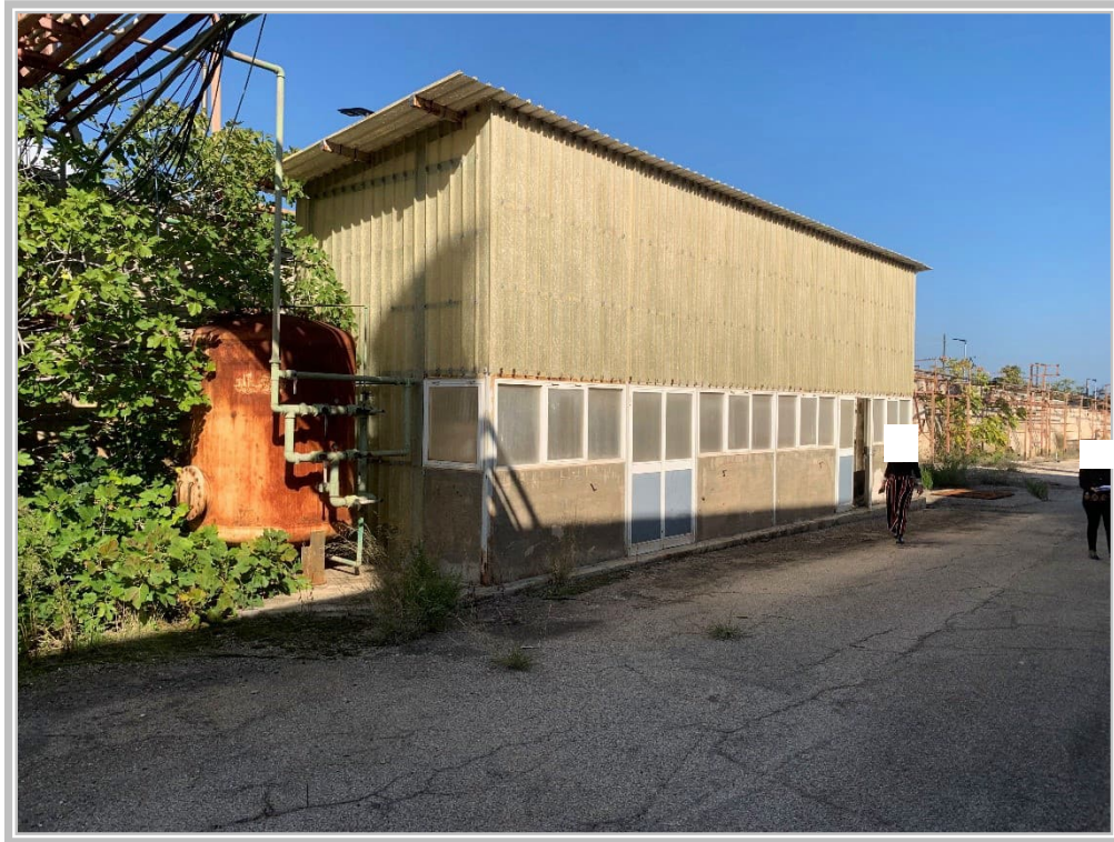
Foto n. 11 : Lotto 8 – Locale impianto addolcimento acque.
