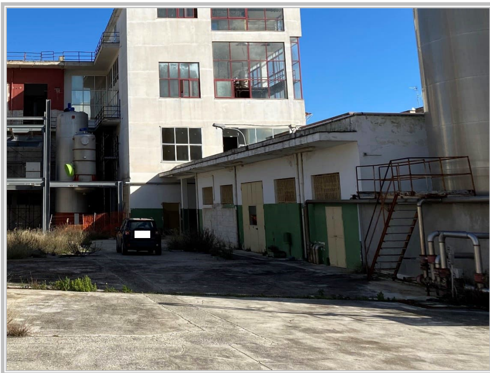
Foto n. 17 : Lotto 14 – Magazzino “Olio vergine e olio extra”
