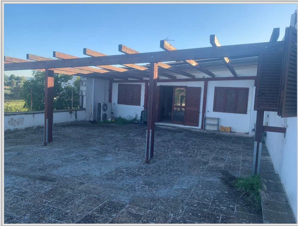
Foto n. 7 : Lotto 4.1 – Abitazione custode
